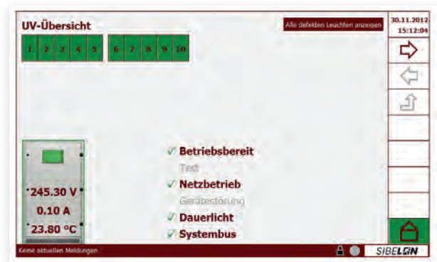
Übersicht der angeschlossenen Unterstationen
